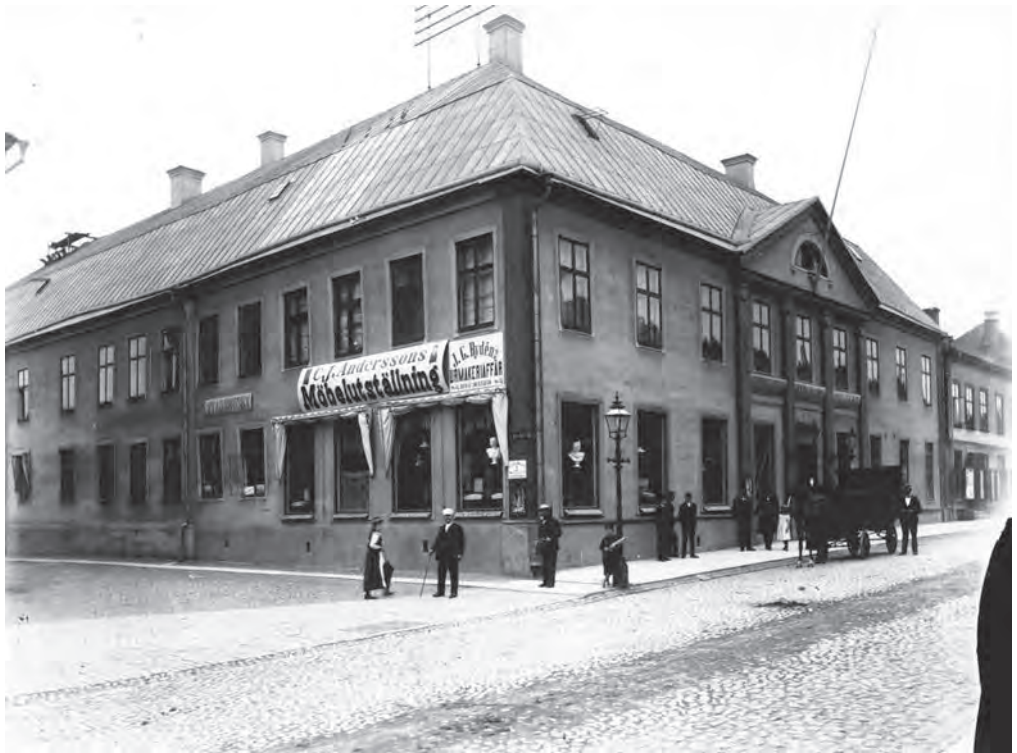
Stadshuset vid Hovrättstorgets västra sida bakom Gamla Rådhuset var byggt på 1780-talet och brann ned 1965. Detta hus kallades "Stadshuset" under 1800-talets senare del och 1900-talets början. Det inrymde då bland annat restaurang, samlingslokaler och café. Foto omkring 1900. Foto: Rylanderska fotosamlingen, Jönköpings läns museum.
